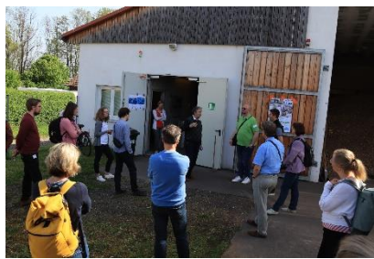
Hackschnitzel-Heizwerk in Baitz - lokale gemeinsame Wärmeversorgung
